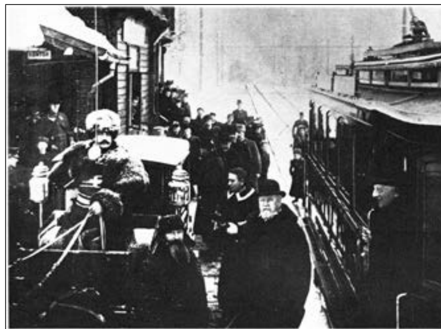
Kong Oscar II på befaring av Holmenkollbanen vinteren 1898 - et par måneder før den offisielle innvielsen fant sted.
