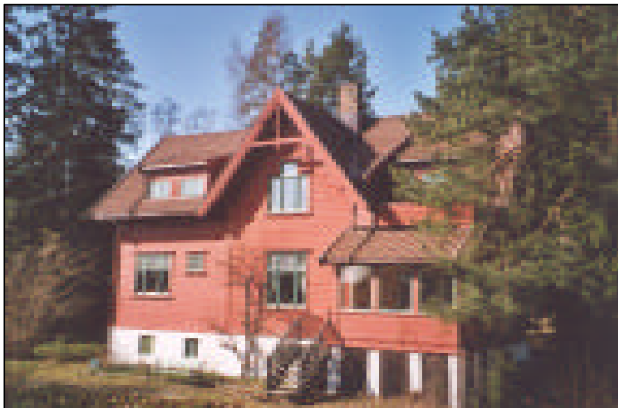
Ferdighus nr. 7 fra Skådalen Trævarefabrik, "Skådalens perle", Skådalsveien 31. Huset har gjennomgått påbygging (til venstre på bildet) og endring (vinduer på taket). Foto: Finn Holden
