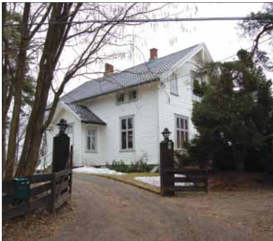
Grimelundsveien 7, rett overfor Emanuel Vigeland-museet. Huset ble bygd i sveitserstil i 1899 uten innlagt vann og strøm. Foto: Finn Holden.
